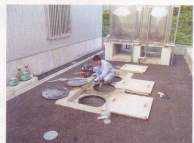
現場検査風景
