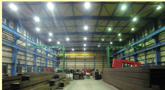
水銀灯をLED照明に交換した工場
