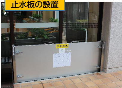
止水板の設置
