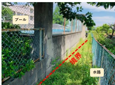
(プールの擁壁部分の現況写真)
