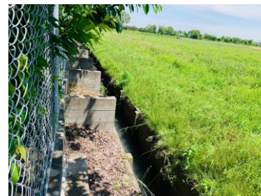
(グラウンド南側のフェンスの現況写真)
