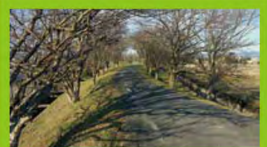
光行土居 (写真の場所は小都市域) 河川の氾濫を防ぐ土手を街道に利用しています。
