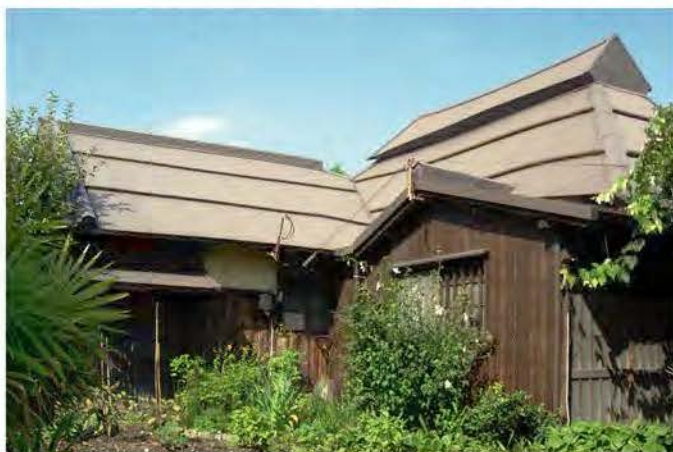
解体前の坂本繁二郎生家
