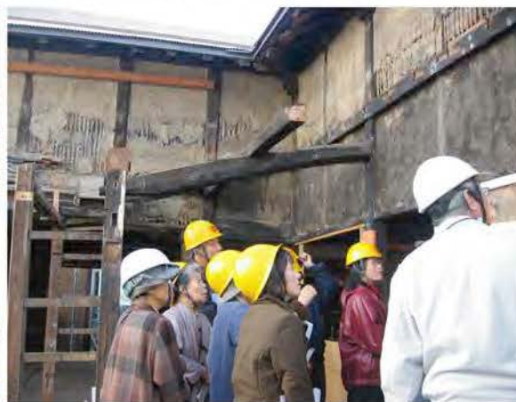
解体工事現場公開
