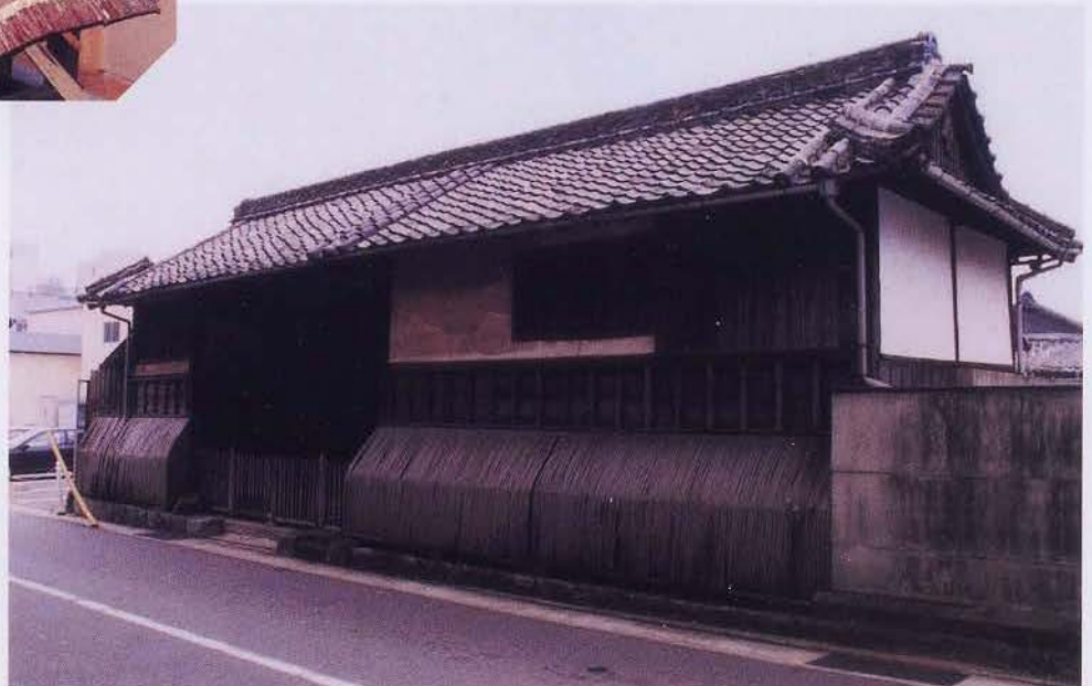
移築前の三島邸の長屋門(北西から) (’98年10月30日撮影)
