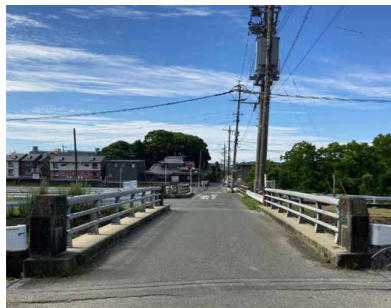
二ツ橋 (手前が男橋、奥が女橋)
