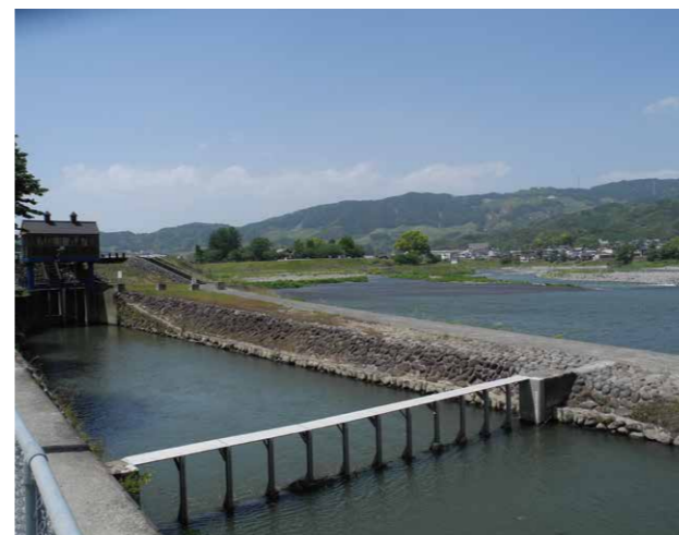
現在の大石堰取水口
