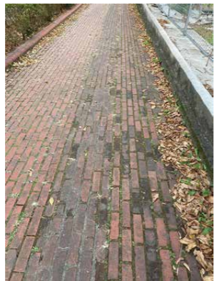
東側の歩道の一部に、開通当時のレンガが残る
