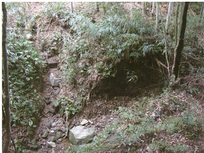
17 南谷水門の現状。堤体の断面が露出した状態。
