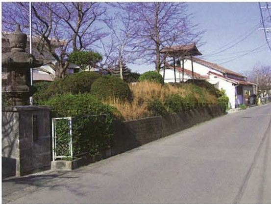
37 納骨堂脇には、現在も土塁の一部が残る。
