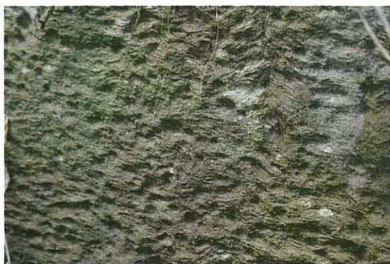
12 大学稲荷前の列石(右)と 13 石材の表面加工の様子(左)。石材を現場に据え付けた後に、工具で表面を滑らかにしていく。表面には工具の痕跡として、細かい凹凸が残っている。
