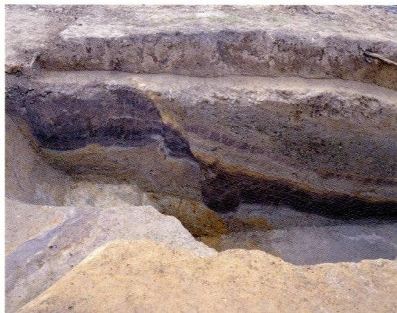
地下に残存していた上津土塁跡の版築土層。極めて硬く突き固められているが、地震動によるズレが見られる。
