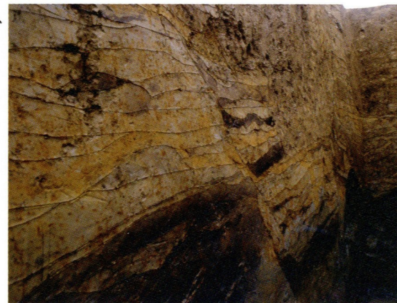
地下に残存していた上津土塁跡の版築土層。極めて硬く突き固められているが、地震動によるズレが見られる。
