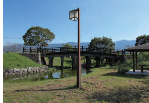
図 9-2-7 照明 (大橋歴史公園/久留米市)
