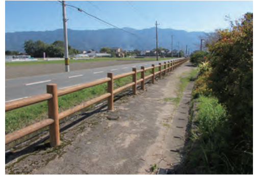
図9-2-2 防護柵 (大橋歴史公園/久留米市)
