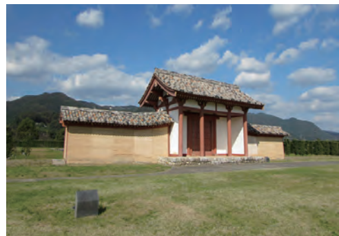
図 9-2-10 南門と築地塀の部分復元 (肥前国庁跡/佐賀市)
