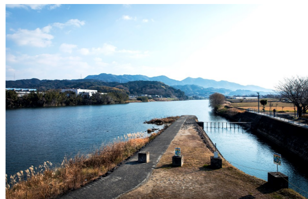
大石堰の左岸にある分水箇所。右が水路でここから筑後川の水をうきは～田主丸方面に送ります
