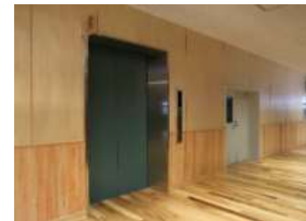
エレベーターの設置
