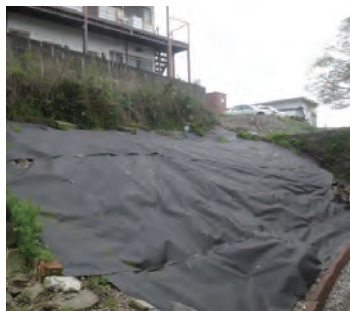
③風で飛ばないよう、固定ピンなどでおさえます
