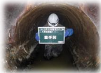
管更生 施工前
