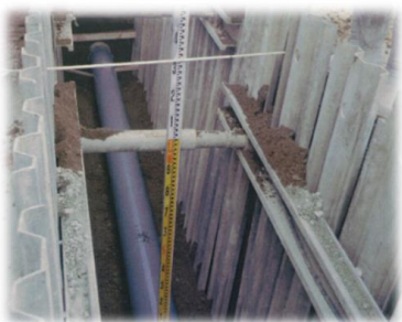
管路の布設状況
