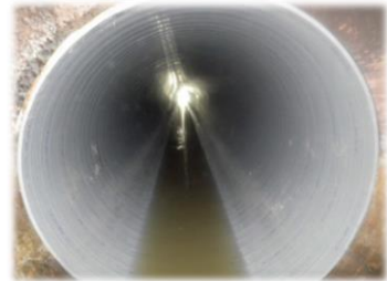
管更生 施工後
