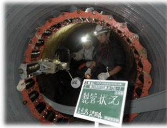
管更生 施工中
