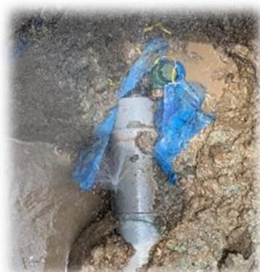
ビニル製配水管の漏水状況
