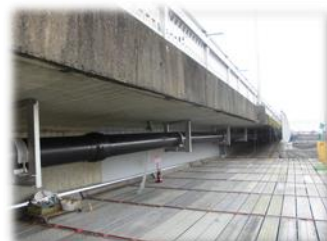
管布設替 施工後（左岸側）
