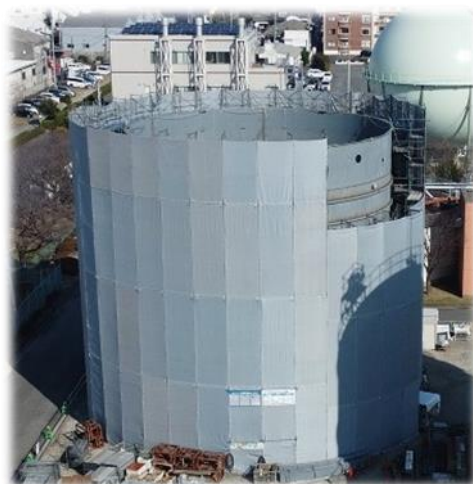
消化槽改築工事状況（令和5年12月末時点）
