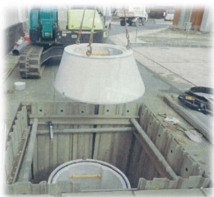
マンホールの設置状況
