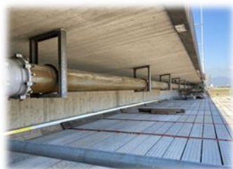
管布設替 施工前
