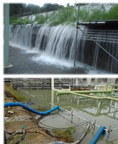
豪雨により浸水した沈砂池
