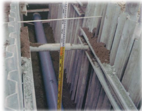
管路の布設状況
