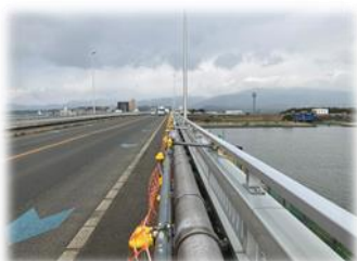
管布設替 仮設管布設中
