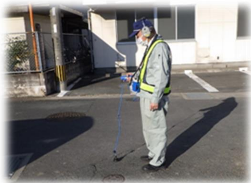
漏水調査の実施状況
