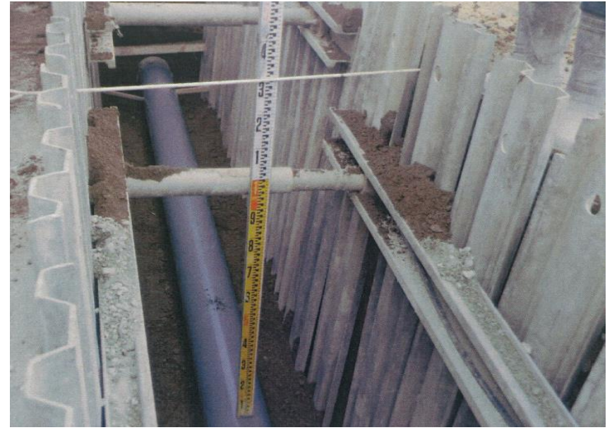
下水道管を布設する様子
