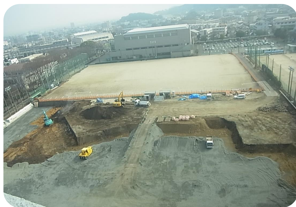
久留米大学雨水貯留施設築造工事施行状況
