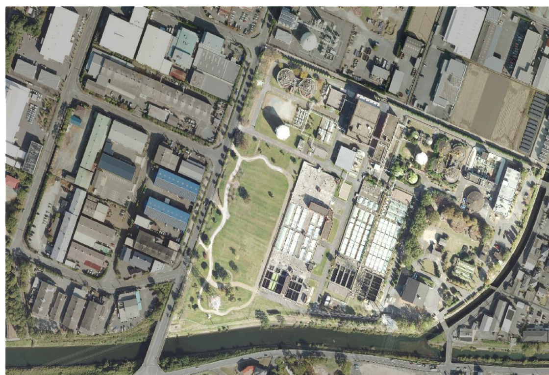
中央浄化センター
