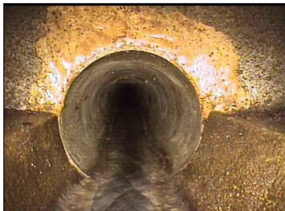
下水道管路内の様子
