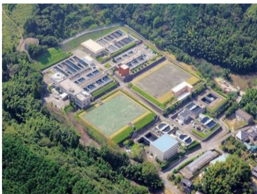
放光寺浄水場
