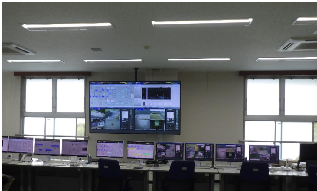
放光寺浄水場監視制御システム更新工事
