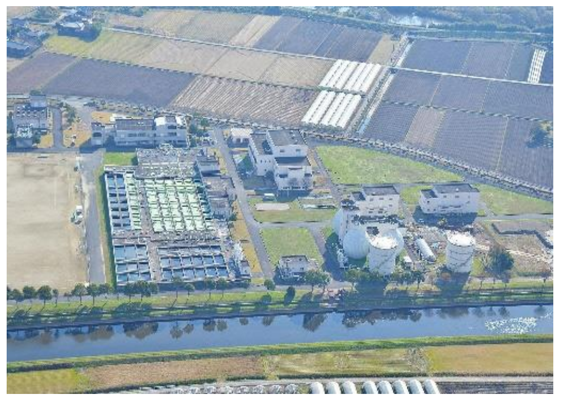
南部浄化センター
