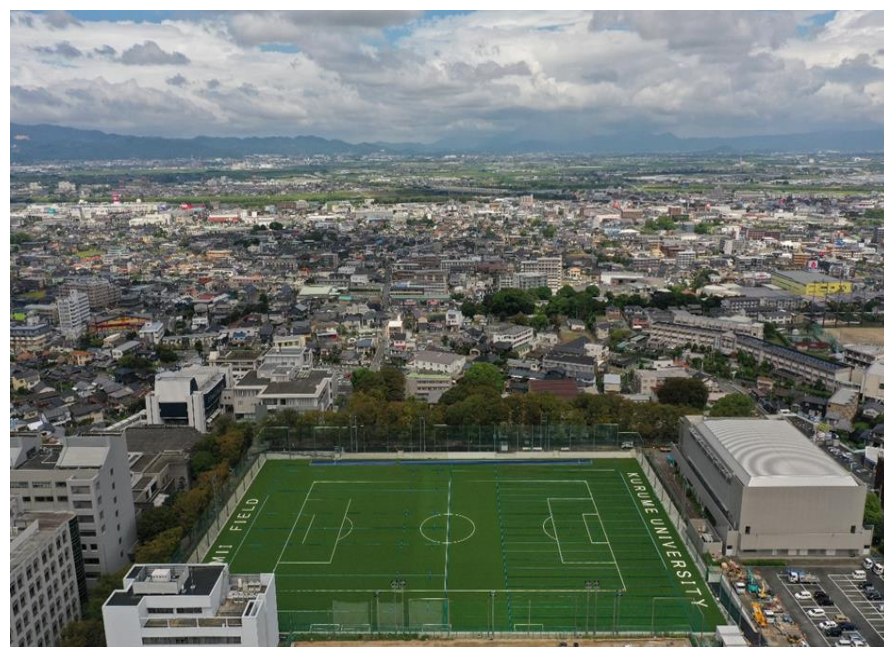
久留米大学雨水貯留施設築造工事完了状況
