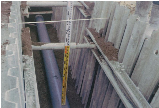
下水道管を布設する様子
