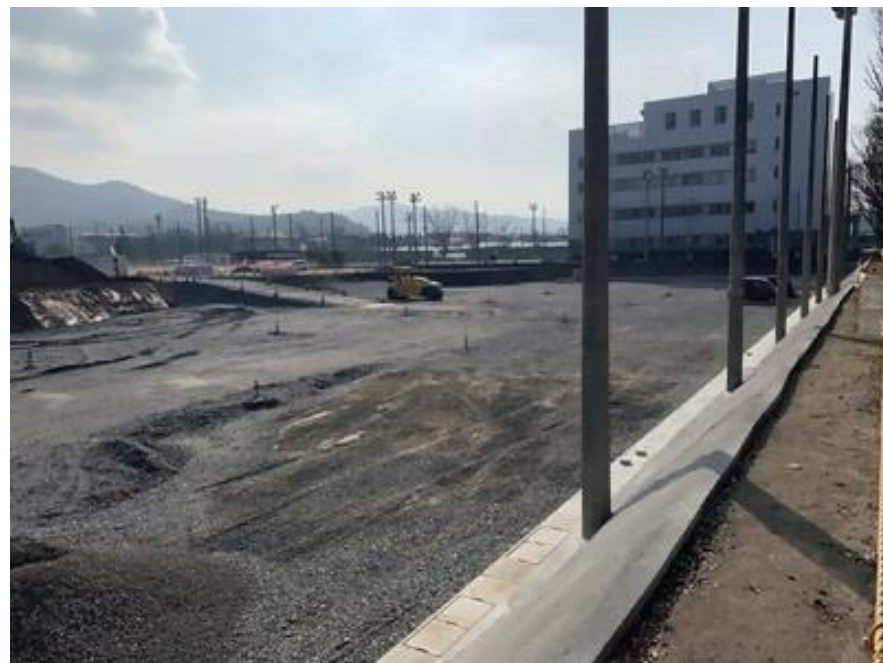
久留米大学雨水貯留施設築造工事施工状況
