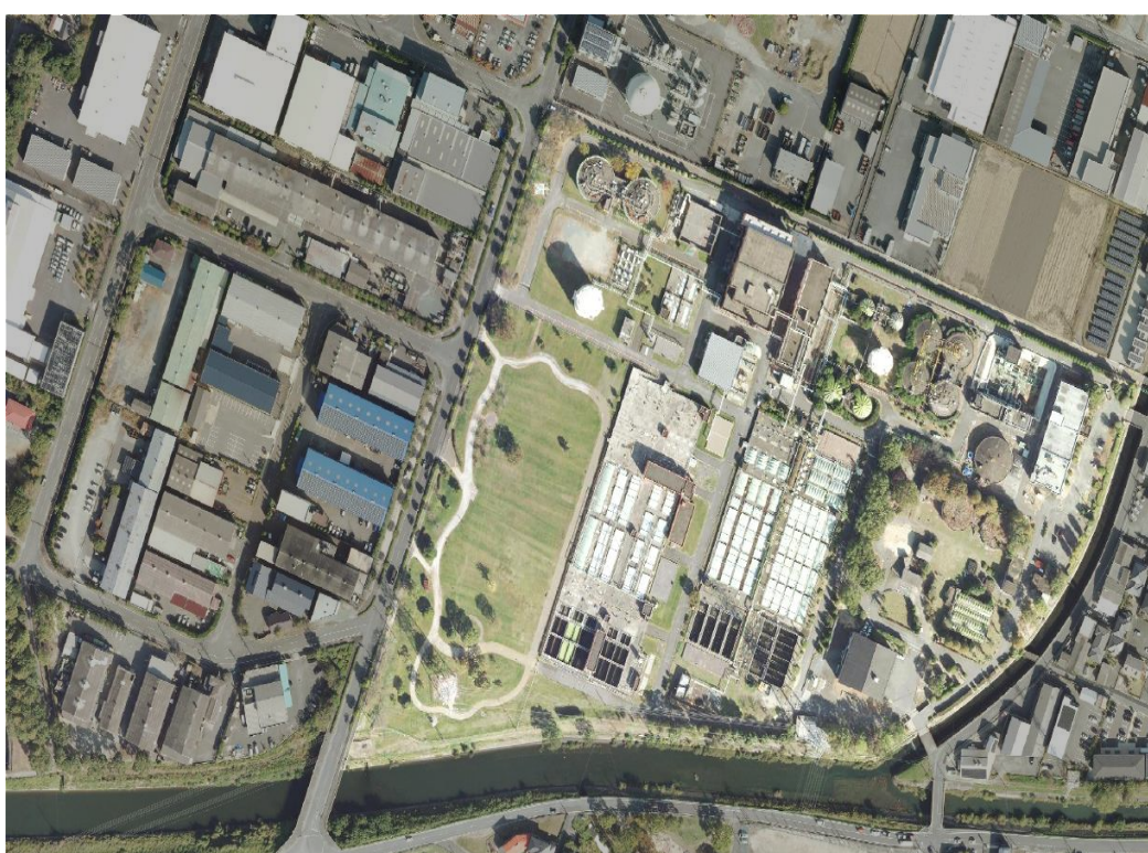
中央浄化センター
