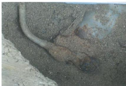
(鉛製給水管からポリエチレン管に更新した状況)
