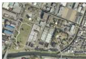
中央浄化センター
