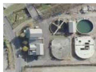
田主丸浄化センター
