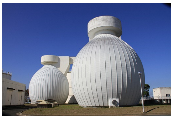
▲ 消化槽（南部浄化センター）
