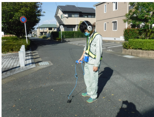
▲ 漏水調査の様子
