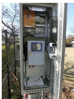
▲遠隔監視装置による残留塩素の測定
