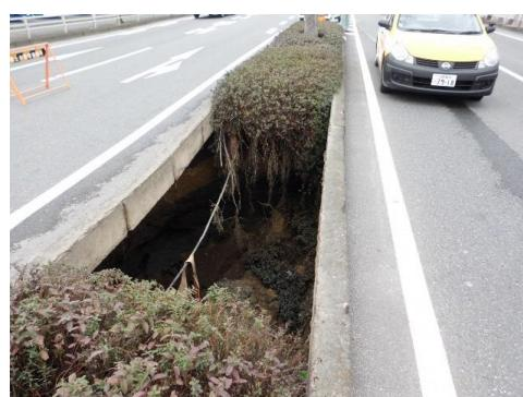
▲ 下水管路破損による道路陥没の様子【平成 24 年度 東櫛原町】
