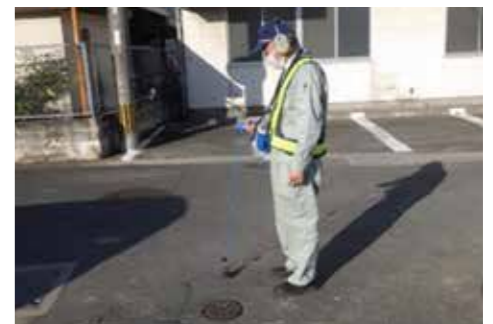
漏水調査の様子
