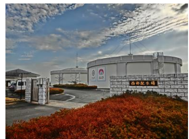
③西部配水場(配水池)
