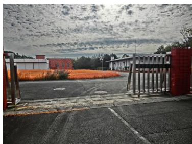
②藤山配水場(配水池)
