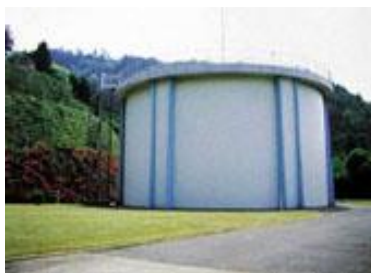
④山本配水池
