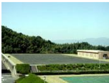
①放光寺浄水場(配水池)
