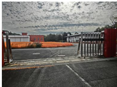
②藤山配水場(配水池)
