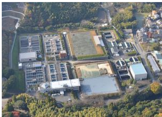
放光寺浄水場
