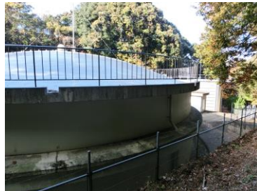
⑤高良内配水池
