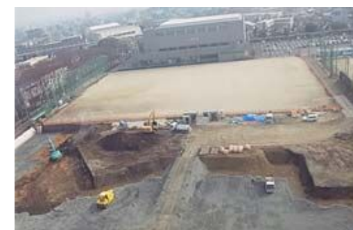
久留米大学の雨水貯留施設工事の様子
