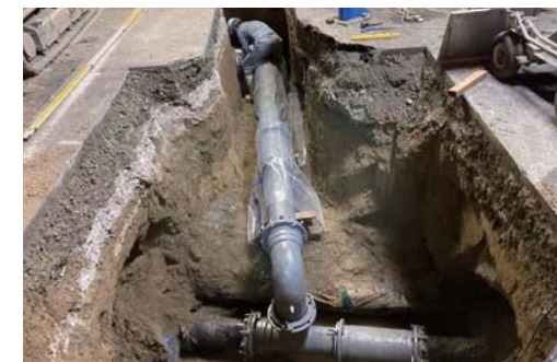
水道配水管の更新の様子
