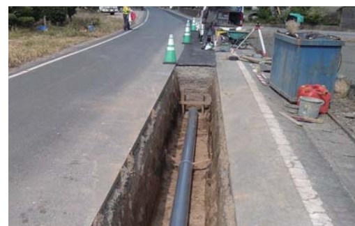
下水道の布設の様子
