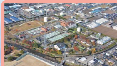
●中央浄化センター(津福本町)
