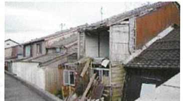
外壁や窓が開放
