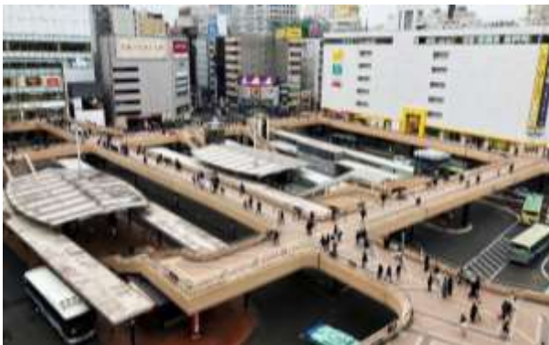
▲ペデストリアンデッキによる歩車分離(仙台市)
