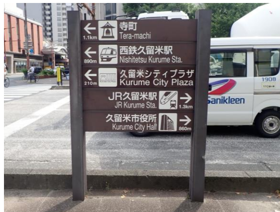
国道209号の誘導サイン
