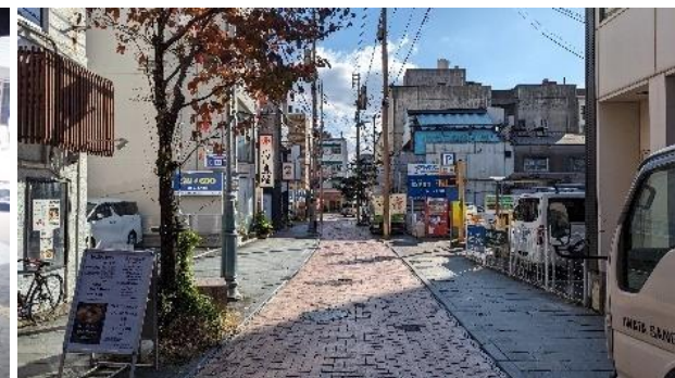
■ 老朽化し凹凸のある路面
