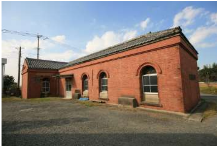
<三井寺ポンプ場>
