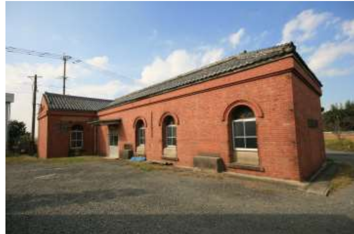
<三井寺ポンプ場>
