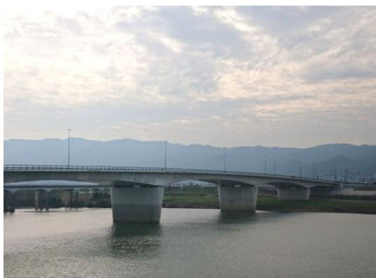
<(主)久留米筑紫野線 神代橋>
