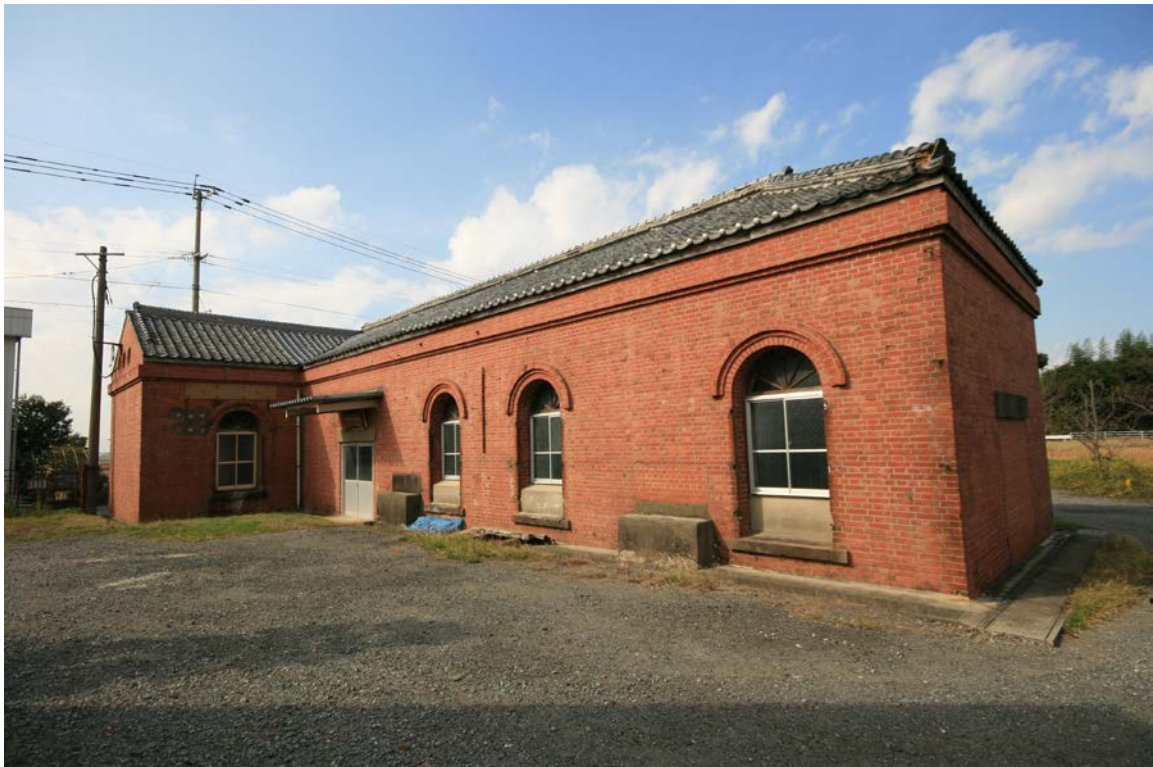
<三井寺ポンプ場>
