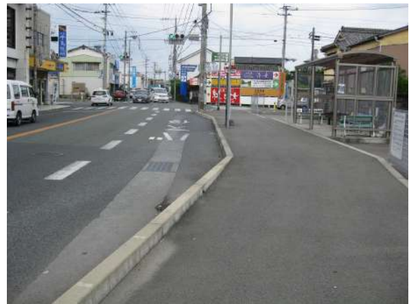
▼ バスベイ整備の事例(国道210号)
