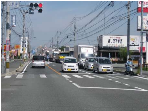
▼ 右折レーン整備の事例(八軒屋交差点)
