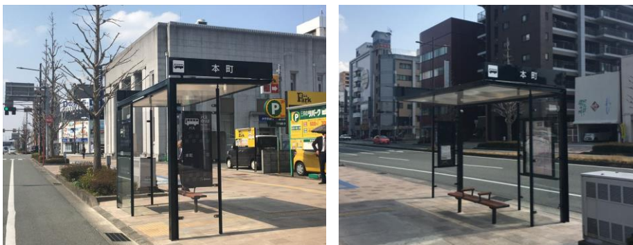
本町バス停(西鉄久留米方面)整備状況
