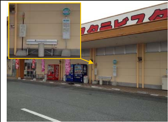
標柱タイプ停留所設置状況(アスタバス三根店)
