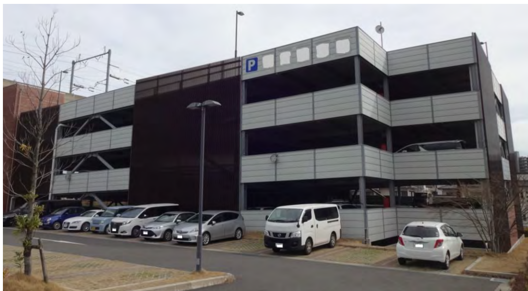
図：自走式立体駐車場の例
