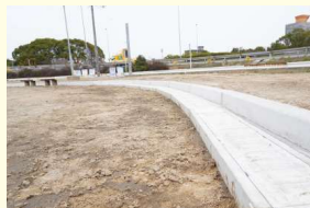
地上でも、園内に降った雨水をためられるよう縁石を設置中
