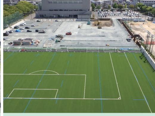
【久留米大学貯留施設】久留米大学のグラウンドを掘り下げて、約21,800㎡の水をためることができるようになります。写真は半分が完成している様子です。
