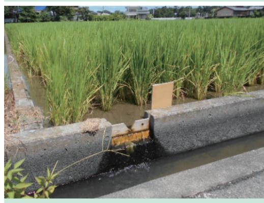
【田んぼダム】水田の排水口に水位調整ができるせき板を設置し、時間をかけてゆっくりと水路に水を流すようにします。
