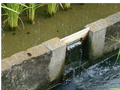
木製 コの字型のセキ板を設置中
