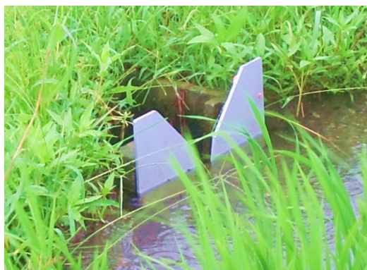
プラスチック製 V字型のセキ板を設置中
