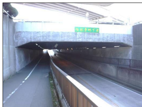
大型カルバート（梅林寺地下道）
