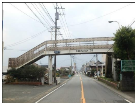
横断歩道橋（山川歩道橋）
