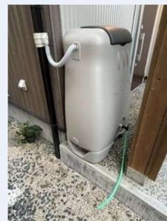
雨水貯留タンクの設置事例（250ℓ）
