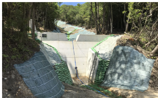
● 林地災害復旧完了の状況（様子）
