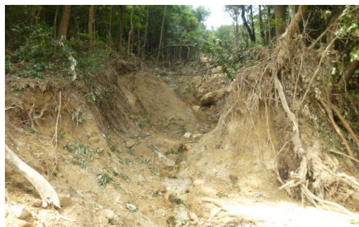
● 土砂崩れの状況
